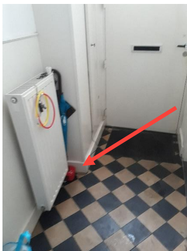
Figuur 3 – meetopstelling schade entree
