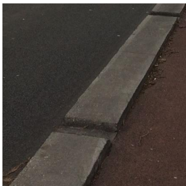
Figuur 2 - verhoogde wegmarkering van beton
